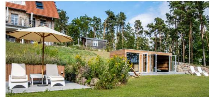
Hier sieht man die Angliederung des Wellnesshauses im Garten an das Hauptgebäude. Leicht versetzt nach unten liegt es in unmittelbarer Nähe zum See.
